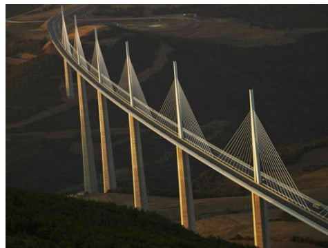
Viaduc de Millau - Aveyron
