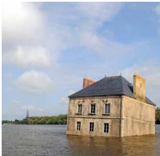
LA MAISON DANS LA LOIRE, COUÉRON © BERNARD RENOUX/LVAN
