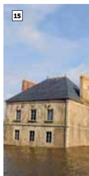
MAISON DANS LA LOIRE © B. RENOUX/LVAN
